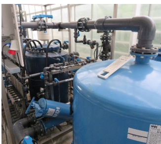
Figuur 2: Rechtsboven: bypass doseerunit. Links en rechtsonder: mengbak doseerunit.
