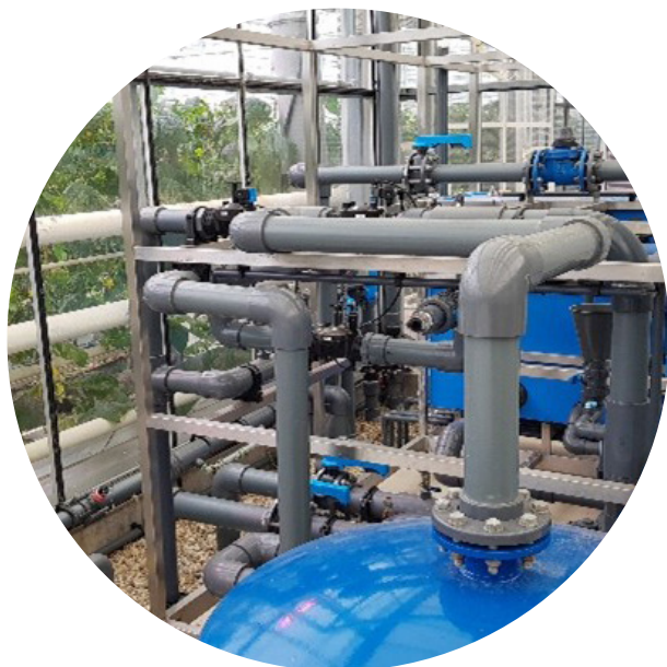
Figuur 2: Rechtsboven: bypass doseerunit. Links en rechtsonder: mengbak doseerunit.
